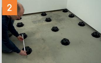
Beim Aufstellen der ersten Terrassenlager richten sich die Abstände der Lager unter den Schienen nach der statischen Belastbarkeit der Schiene (A) und die Abstände in der Breite nach der Plattenbreite (B). Wichtig: Der Abstand (C) der Lager unter der ersten und letzten Plattenreihe ist um 91,4 mm geringer als zwischen den mittleren Reihen (B). Maßübersicht Seite 4.
