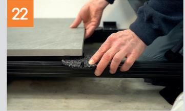
Nach Auflegen wird die erste Platte am Wand-Fix und am S-Fix ausgerichtet und eingelegt. Der M-Fix wird so nachgeführt, dass er fest an der Platte anliegt.
