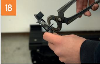
Dann werden die M-Fix auf der 1. Schiene dem Plattenmaß entsprechend vermessen und aufgesetzt (noch nicht verschraubt). Mit Hilfe einer Kneifzange werden zuvor die nicht benötigten Abstandsstege entfernt.
