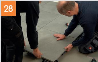
Die letzte Reihe der Fläche sollte nach dem gleichen Schema verlegt werden wie die erste: Die M-Fix platzieren; danach die S-Fix 2 cm links und rechts daneben verschrauben. Dann können die letzten Platten eingelegt werden.
