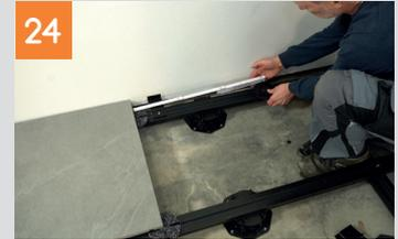
Verschrauben der M-Fix mit der Bohrschraube 4,2x19 mm. Die nächsten Platten werden dann nach dem beschriebenen Prinzip eingelegt.
