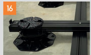
Zur stirnseitigen Fixierung der Platte wird der Wand-Fix mit der Bohrschraube 3,9x19 mm aufgeschraubt. Der Langschlitz dient dabei zum Ausgleichen von kleinen Maßtoleranzen. Direkt neben dem Wand-Fix wird ein M-Fix verschraubt. Die nicht benötigten Abstandsstege werden vorher entfernt.
