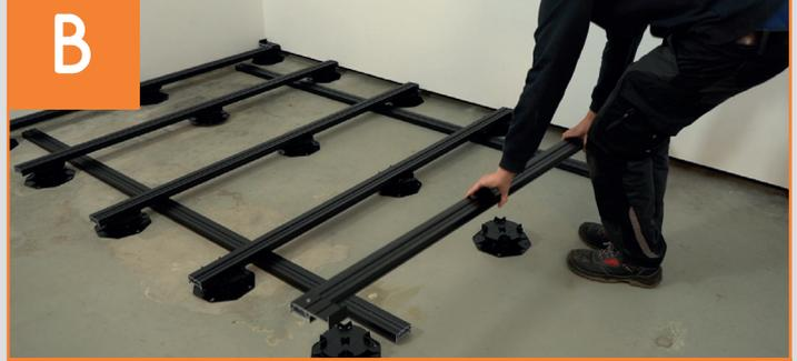
Schienen aufklicken und Abstände auf Plattenbreite ausrichten
