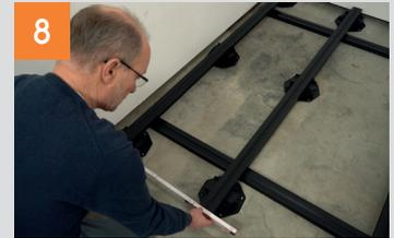
Die folgenden Schienen werden auf die bereits grob ausgerichteten Terrassenlager aufgeklickt. Dabei sollten die Maße von Schiene zu Schiene entsprechend der Plattenbreite kontrolliert werden. Maßübersicht Seite 4.
