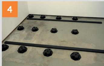
Bevor die Schienen auf die Terrassenlager geklickt werden, wird die Konterlattung, die zur Stabilisierung der Konstruktion dient, ausgelegt. Je nach Bausituation sollte der Abstand max. 300 cm betragen. In jedem Fall müssen mind. 2 Profile gesetzt werden.
