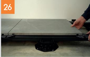
Die Platten werden nun reihenweise verlegt. Dabei wird bei jeder Platte der M-Fix entsprechend nachgeführt. Hinweis: Der M-Fix muss umlaufend nur in der 1. und 2. Reihe verschraubt werden (ein Verschrauben in der Fläche ist nicht notwendig).
