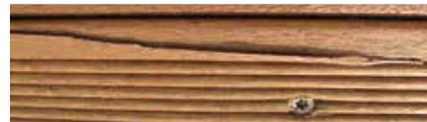
Wie bei der Konstruktion ist es auch in der Nutzung wichtig, die Entstehung von Feuchtenestern zu vermeiden. Eine Unterlüftung ermöglichen Leisten, Abstandhalter oder Untersetzer, die nur punktuellen Kontakt zur Terrasse aufweisen. Blumentöpfe und Pflanztröge sollten grundsätzlich nicht vollflächig am Untergrund aufliegen!
